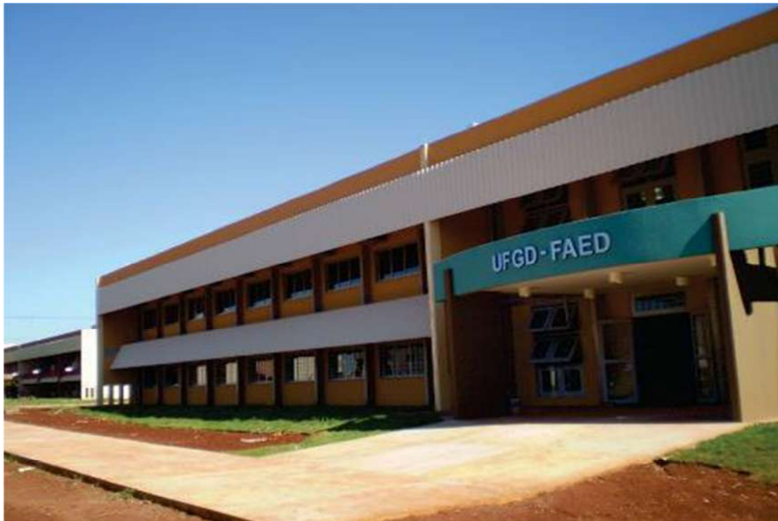
Figura 15 - Faculdade de Educação na Unidade II da UFGD
